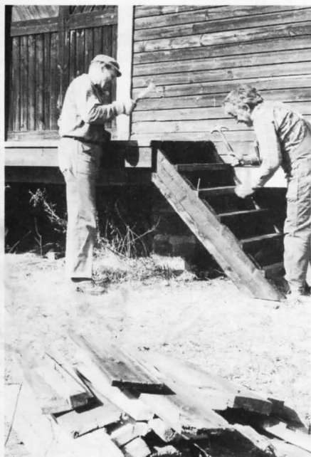
Snickarna som arbetat med restaureringen av Järle Station sen 7:e januari till kommunikationsministerns besök i Järle under sommarmånaderna. Ivar Lidholm från Vassa och Inge Andersson från Ås utanför Nora slår här i sista spikarna på lastkajen vid godsmagasinet.
